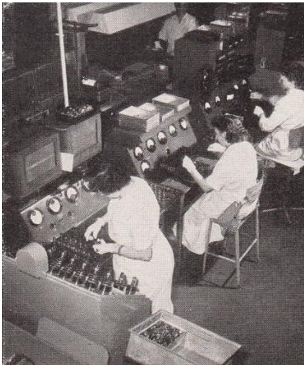
In der Endprüfung durchlief jede Röhre auf Spezialmesstischen eine Reihe von Kontrollen, 1957
