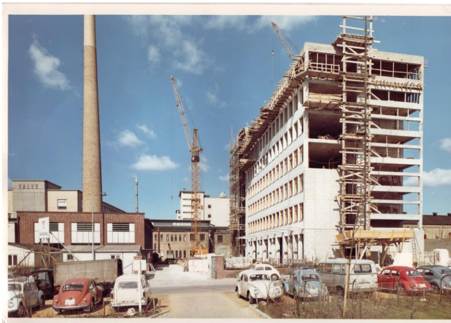
Das M-Gebäude im Bau, 1965
