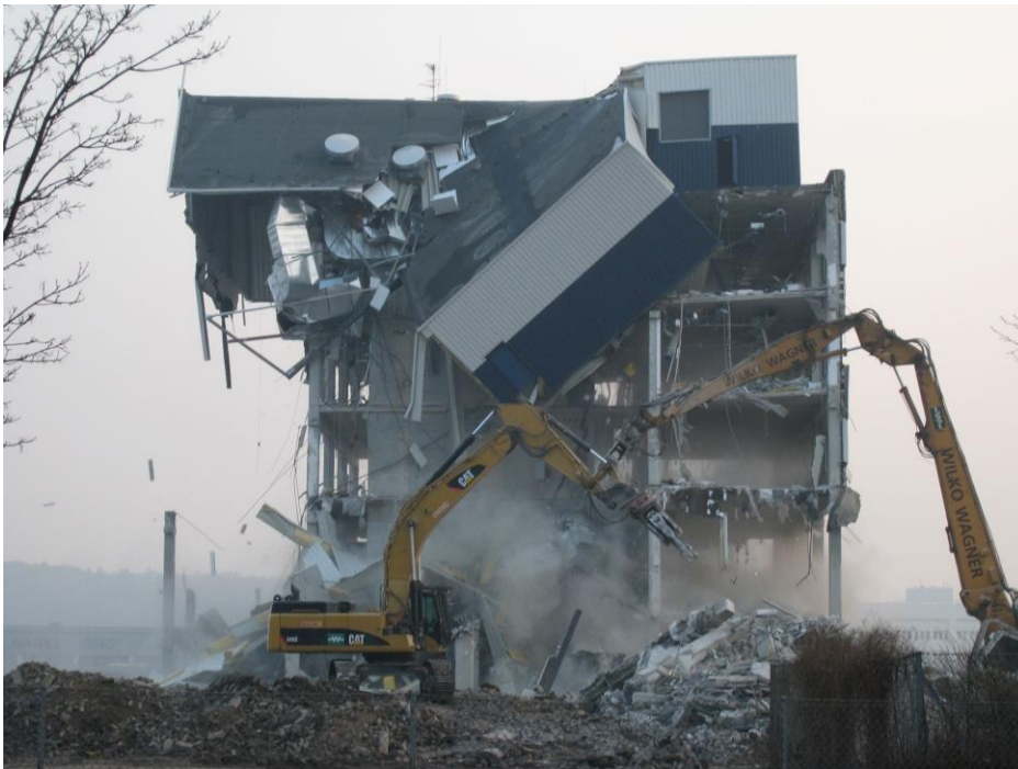
Abbruch Entwicklungszentrum Hausbruch 2/2011 [VNP Bilder 2011 Abriss Hausbruch]
