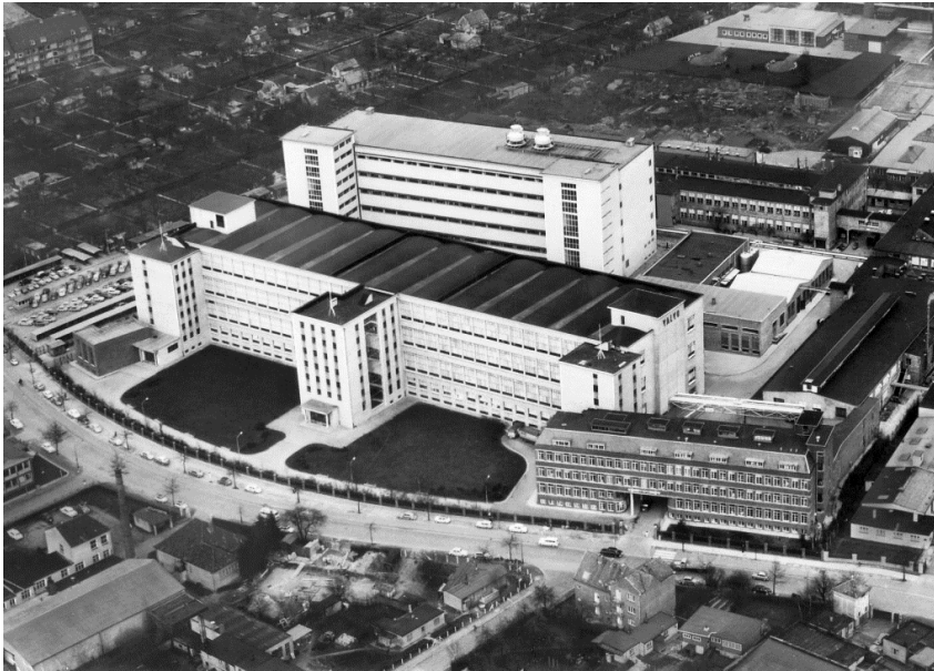
1965: ausgebautes L-Gebäudes und neues N-Gebäude
