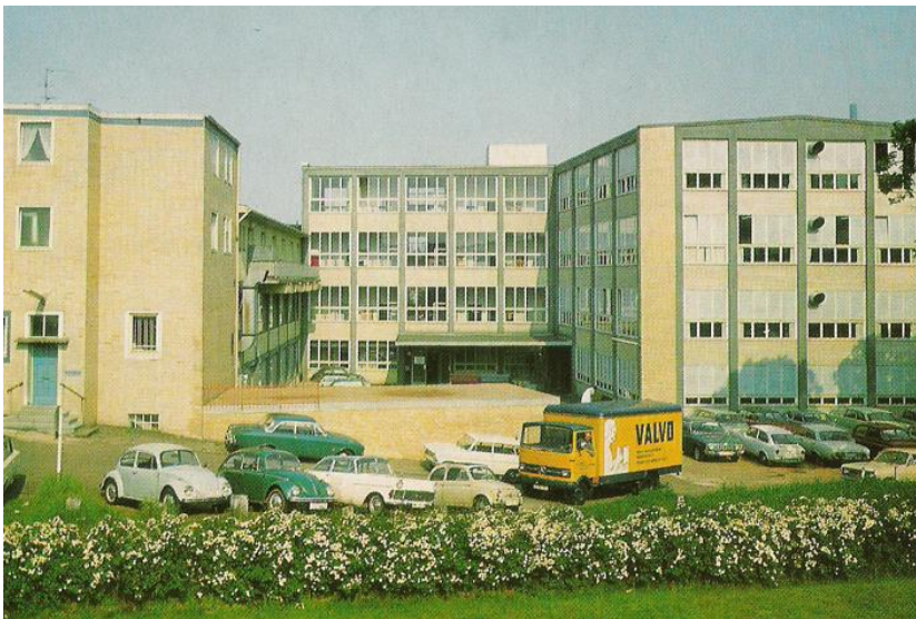
Montage-Atelier Harburg 1969, Seitenansicht, links Altbau, rechts Neubau
