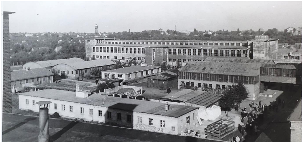
Das K-Gebäude (hinten im Bild) wurde 1941 fertiggestellt. Die Wände und Decken waren als Bunker ausgelegt. Davor stehen Baracken. Aufnahme 1950 vom A-Gebäude aus
