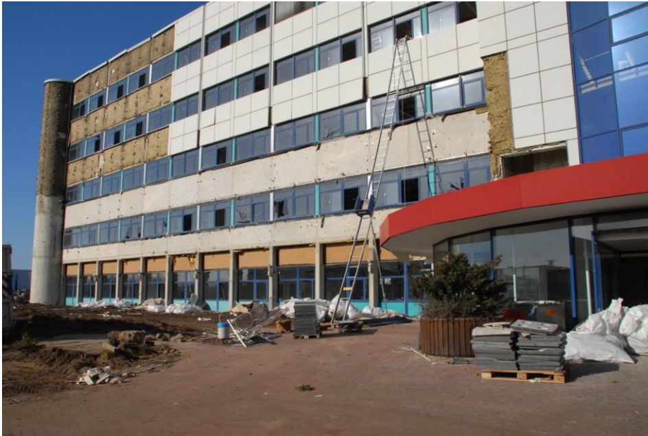
Abbruch Entwicklungszentrum Hausbruch 2/2011 [VNP Bilder 2011 Abriss Hausbruch]
