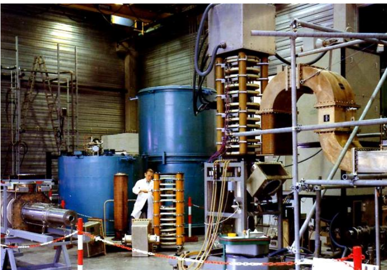
Gebaut und getestet wurden die Groß-Klystrons in einer Halle am Nord-Eingang der RHW, 1988
