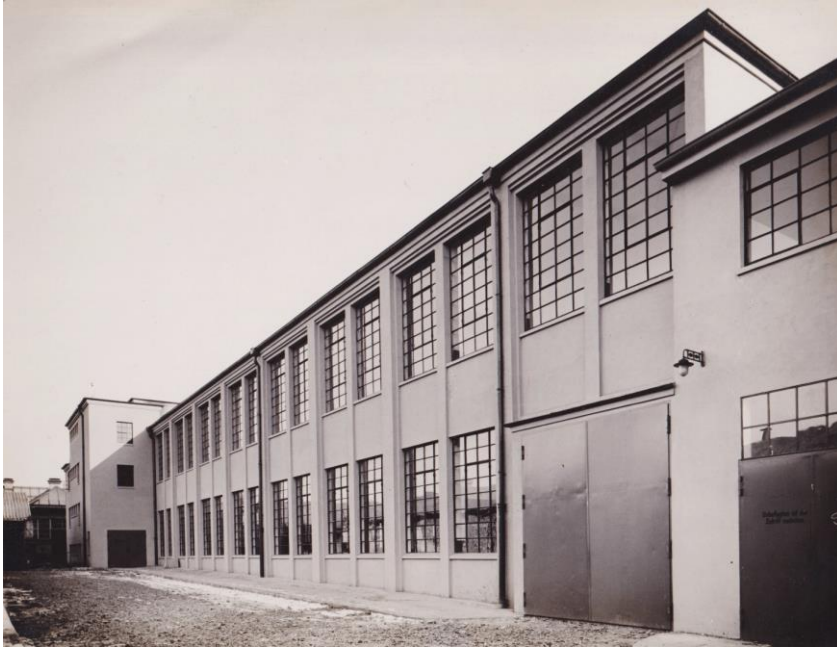
Neubau des C-Gebäudes, 1934
