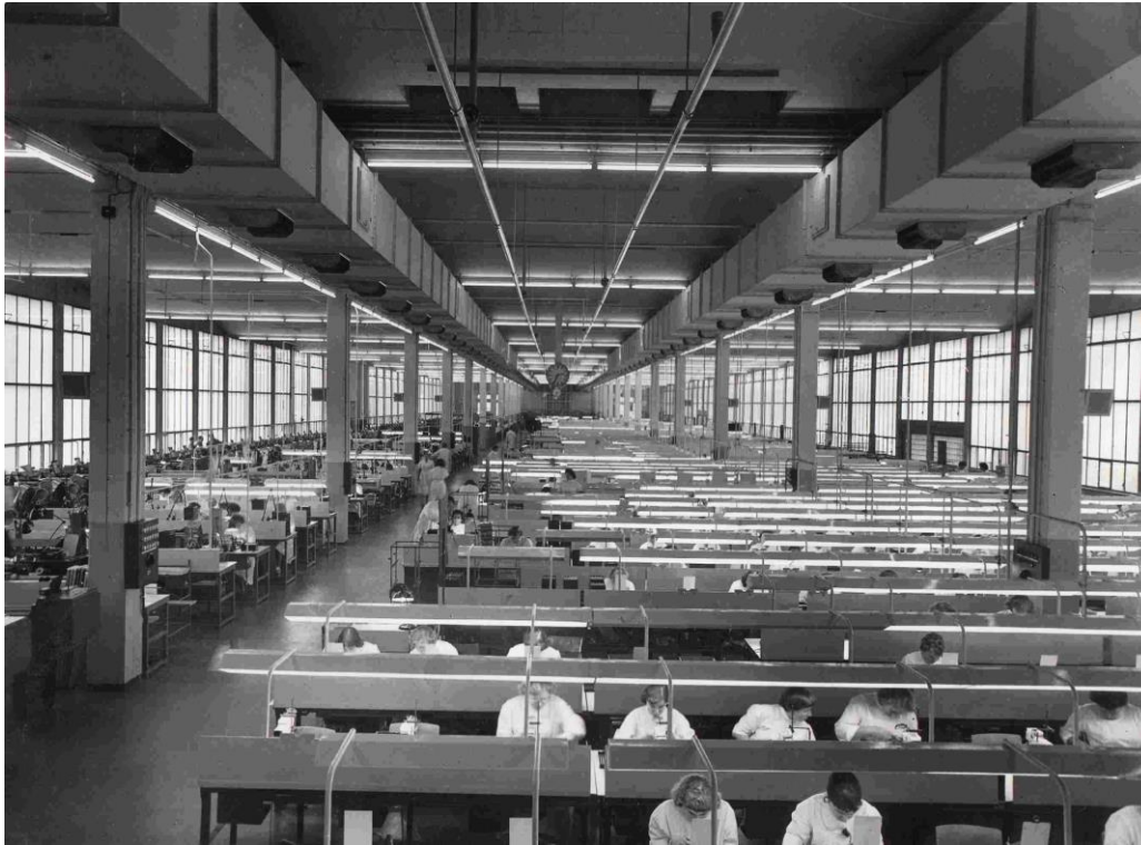
Röhren-Montage im L-Gebäude, ca. 1960 [VNP Bild 082]
