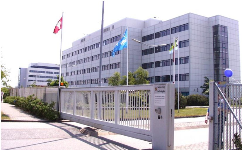
Das OD-Gebäude (links) bestand 1999 schon, wurde aber aus Kostengründen erst 2004 bezogen.
