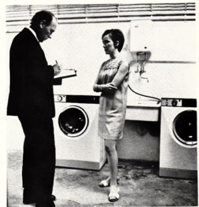
Vier Waschautomaten enthält der große Waschraum, der automatisch be- und entlüftet wird und gleichzeitig als Trockenraum dient. (Im Bild: A. Noack, RHW, und Frau V. Tausch-Loncar.)
