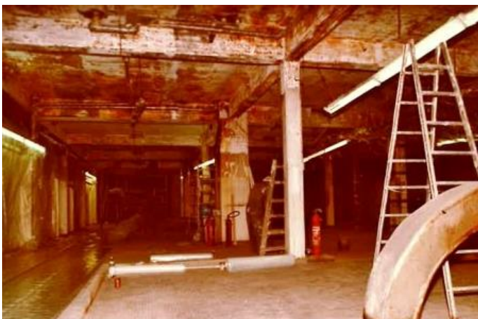
Total Sanierung nach Brand in L-Erde, 1981
