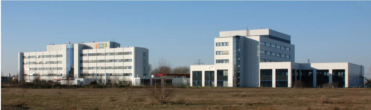
Hausbruch: Links LA-Gebäude, Mitte Kantine, rechts OD-Gebäude [ Link VNP Bilder 1989 Hausbruch ]
