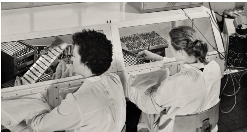
Ätzen von Germanium-Leistungs-Transistoren im C-Geb, 1958
