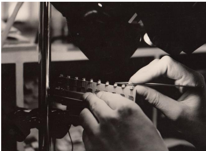
Montage von POB-Kristallen in Transistor-Gehäuse, 1964
