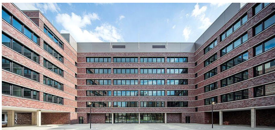
Innenhof des Z-Gebäudes, 2017
