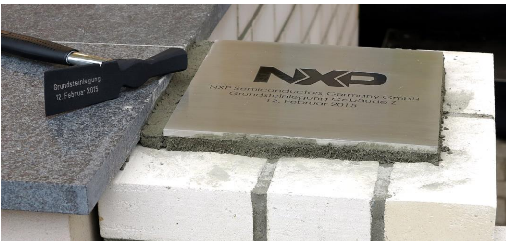
Der Grundstein des Z-Gebäudes, Februar 2015 [VNP Bilder 2015 Grundsteinlegung Z-Geb]
