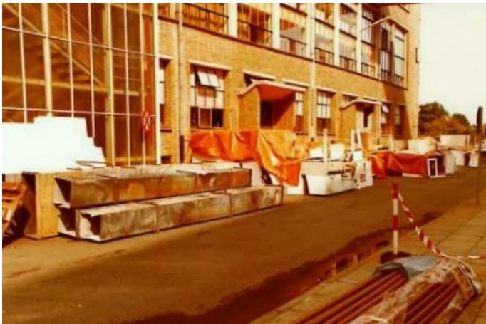
Total Sanierung nach Brand in L-Erde, 1981
